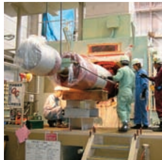
■ 発電機分解点検 20kVという高い電圧を生み出す発電機。電気をつくるための主力機器で、点検時には本体から回転子を抜くなどダイナミックな仕事です。
