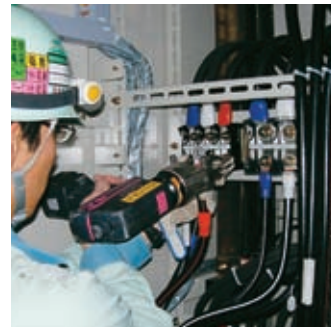
■ 高圧ケーブル配線 発電所の主要機器への電源供給を行う高圧ケーブル配線。大きく、硬い高圧ケーブルの結線から総合試験まで行う電源供給の大事な仕事です。
