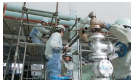
〈配管製作実習〉
