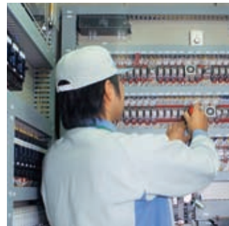
■ 制御ケーブル配線 発電所運転制御の要である制御ケーブル配線。図面に合わせてケーブルの結線から総合試験まで行う、制御系の中心的な仕事です。
