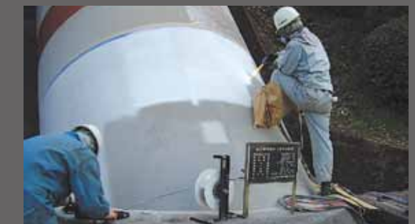
高温で溶かしたアルミ合金を吹き付けて、100年以上錆を防ぐ新技術
