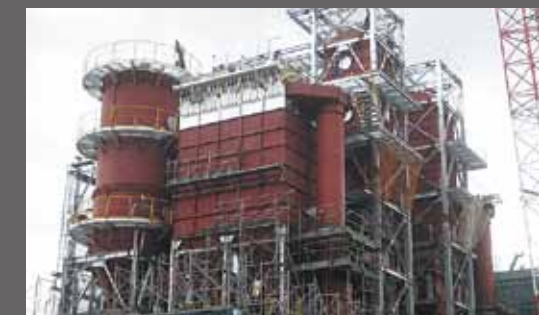
宝満環境センター：熱回収施設建設工事
